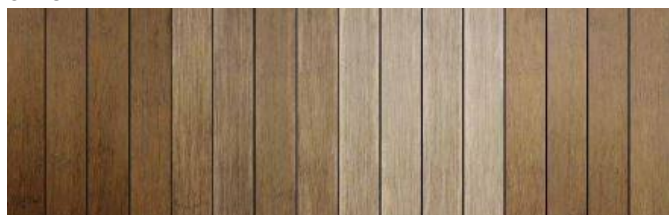
Dopo installazione Doppo 1 anno Doppo la pulizia Dopo manutenzione
